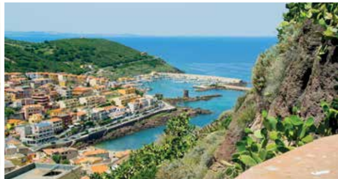
Blick von der Burganlage auf die Marina in Castelsardo.
